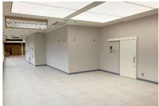
(現地写真(トイレ棟と店舗棟の間のホール))
