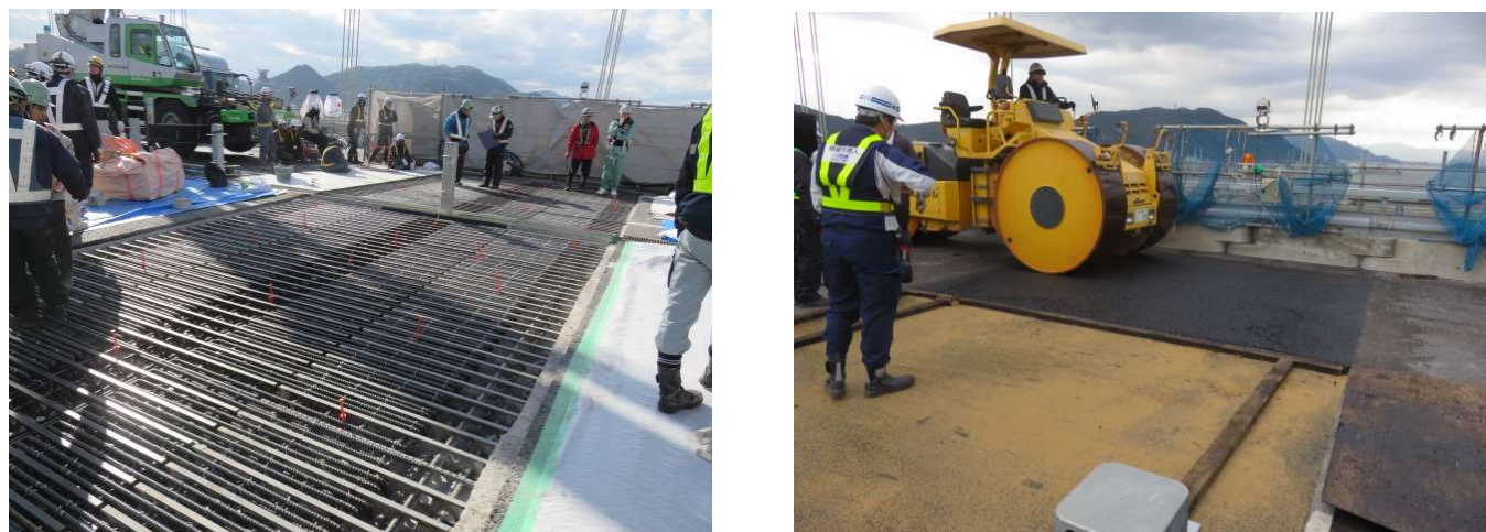
床版の設置、舗装状況
