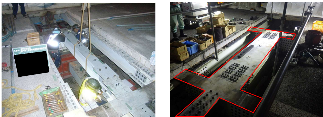
新設支承・横桁・縦桁の設置
