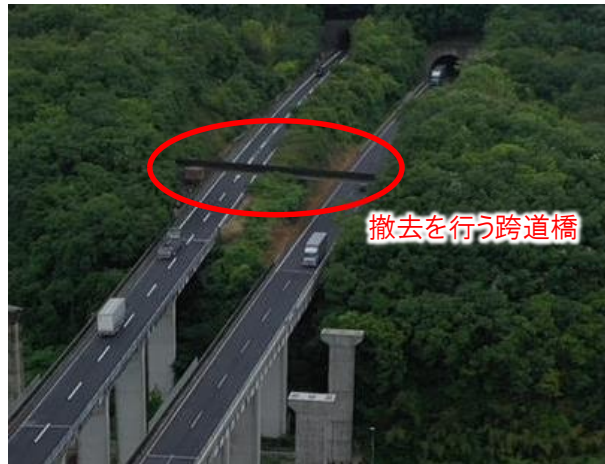
《跨道橋撤去工事》
