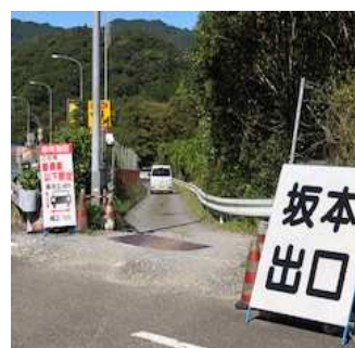
緊急開口部（坂本PA（下り線）） ※運用開始直後
